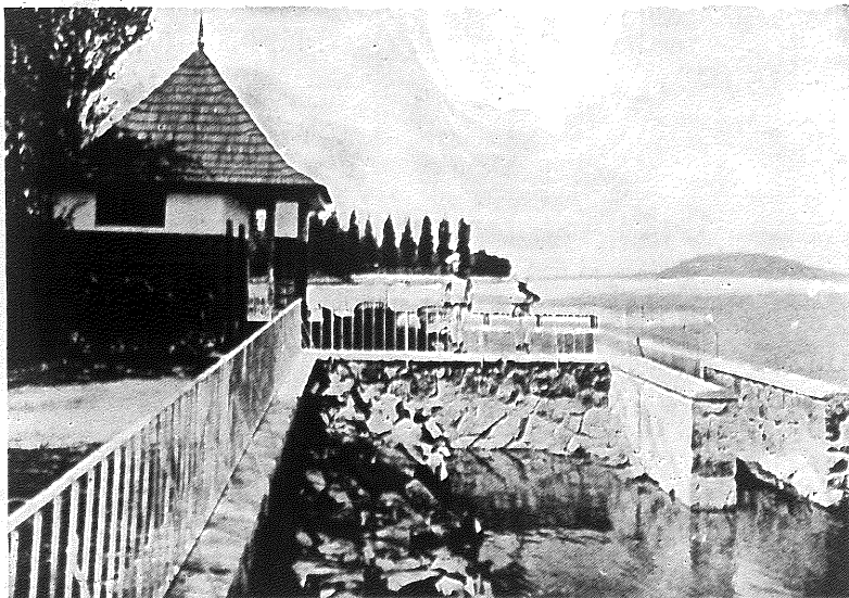
Balatonlelle: Reichl Kálmán építésztanár saját tervel szerint épített és bevált partvédő építkezése. Körmeny Páter felv.
